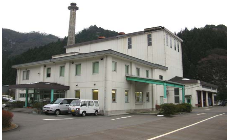
新温泉町クリーンセンター
