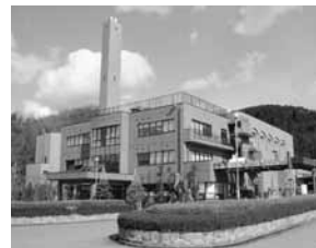
豊岡清掃センター 140 t / 日 H2稼働(16年経過)
