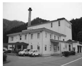
新温泉町 クリーンセンター 30 t / 日 H4稼働(14年経過)
