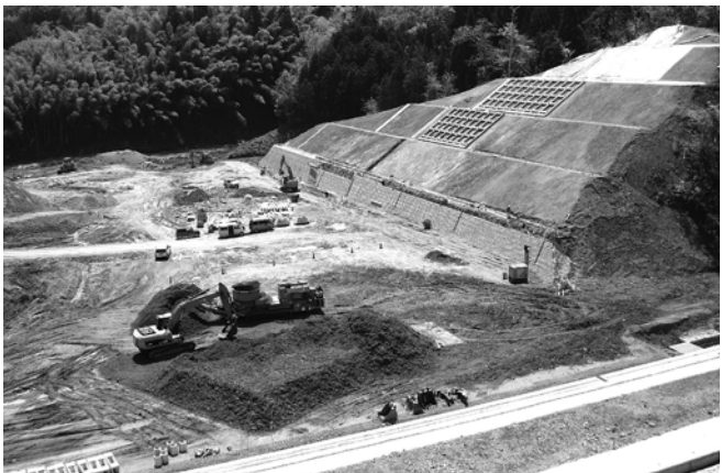
▲敷地造成部の作業状況
