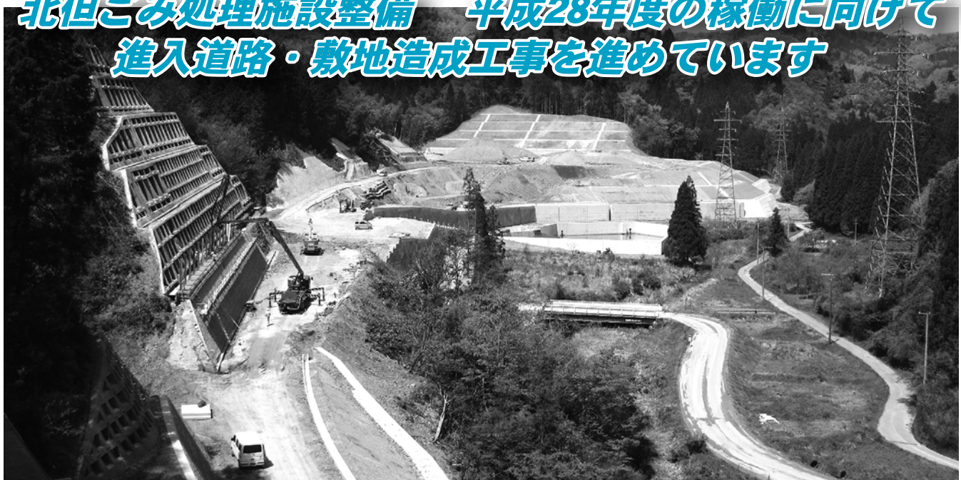
▲敷地造成部(全景)の工事状況
