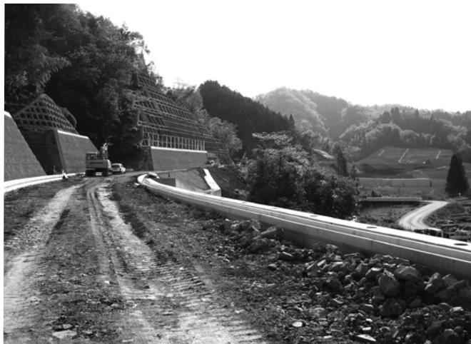
▲進入道路部の作業状況
