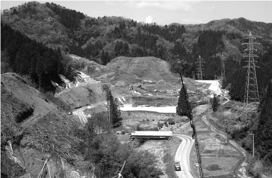
▲敷地造成部(全景)の工事状況
