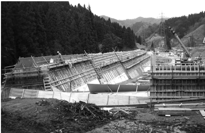
▲敷地造成部の作業状況
