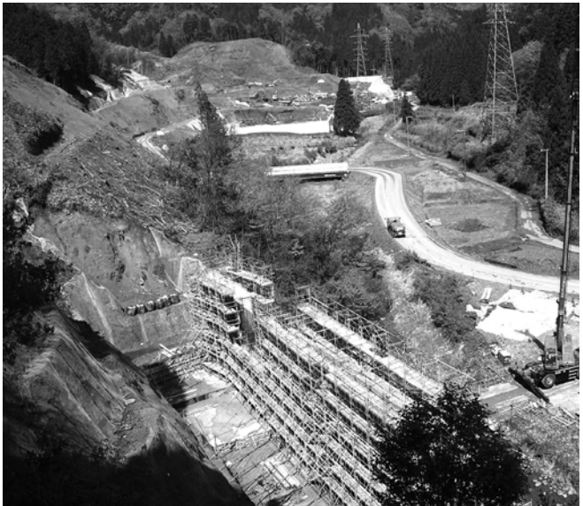
▲進入道路部の作業状況
