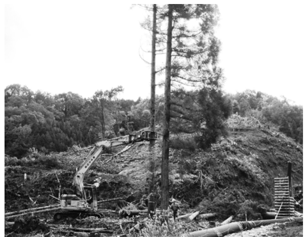
▲敷地造成部の立木伐採状況
