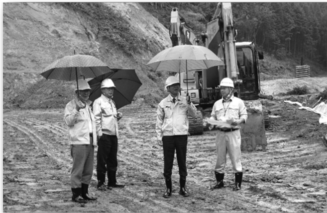
▲正副管理者が進入道路・敷地造成工事現場を訪れ、 工事の進捗状況を確認しました。(H 24.10.2)
