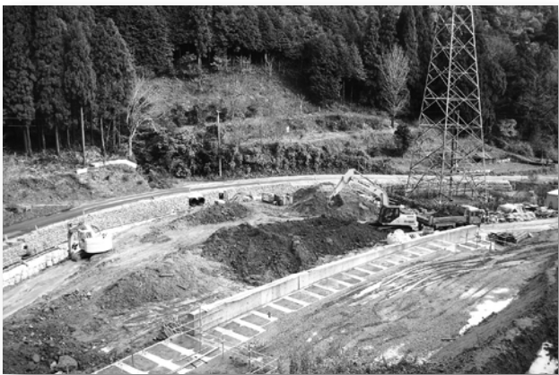
▲ 進入道路部の工事の状況
