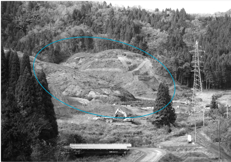
▲敷地造成部(全景)の工事の状況
