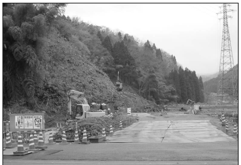
▲ 施工中の進入道路
