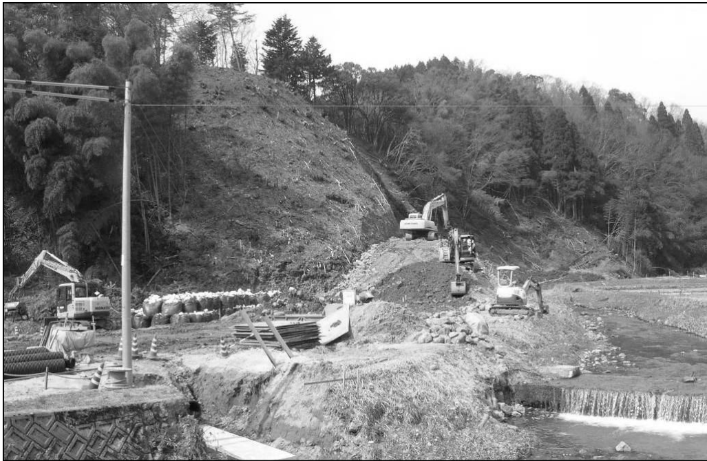
▲着々と進む進入道路工事
