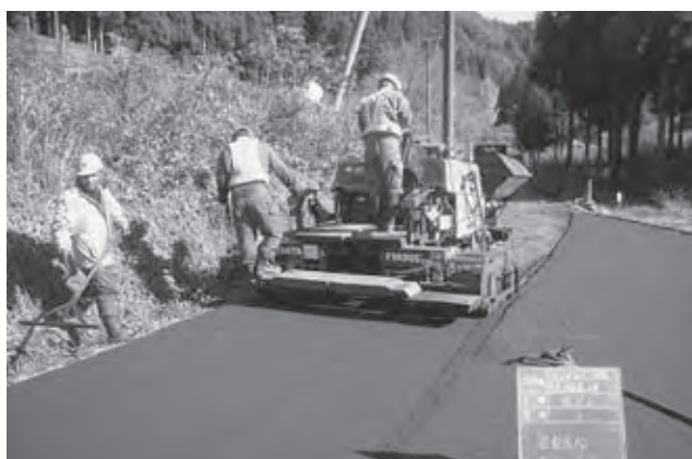
待避所設置工事
